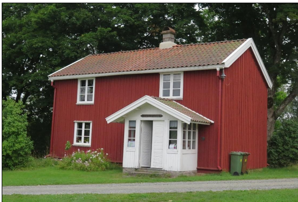
Bostadshuset från sydost efter åtgärder och renovering av skorstenen. Foto Lars Bergström 2022-08-10.
