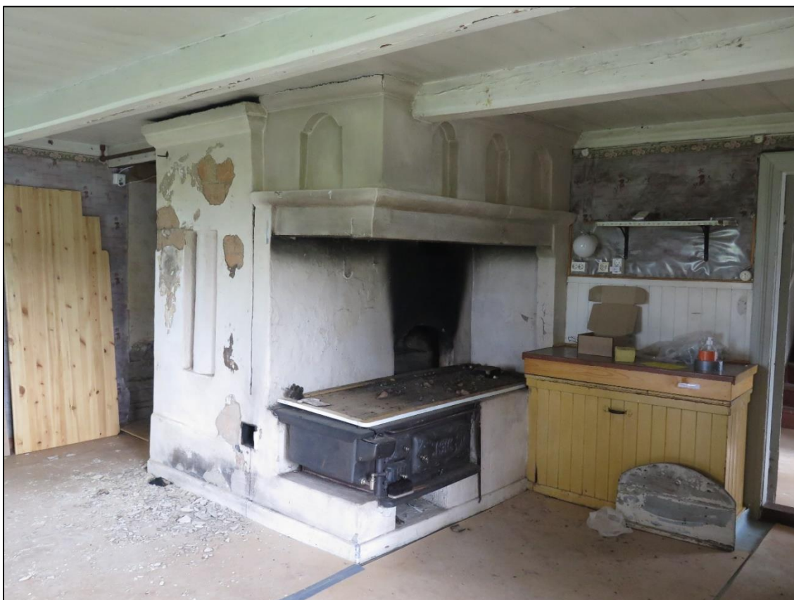
Köket med vedspisen med bakugnen snett ovanför till höger om den och rörspisen bakom vedspisen. Lös färg och delar av lerklining på rörspisen borttaget. Foto Lars Bergström 2022-05-18.
