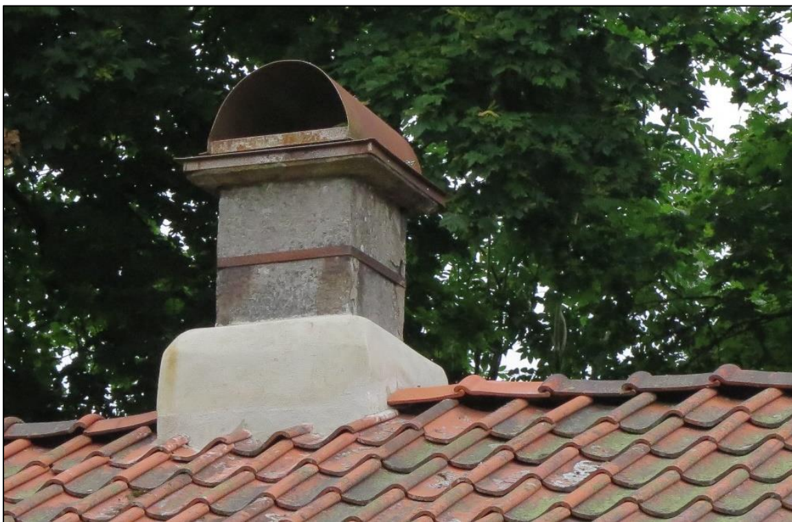
Skorstenen från sydost efter åtgärder. Foto Lars Bergström 2022-08-10.
