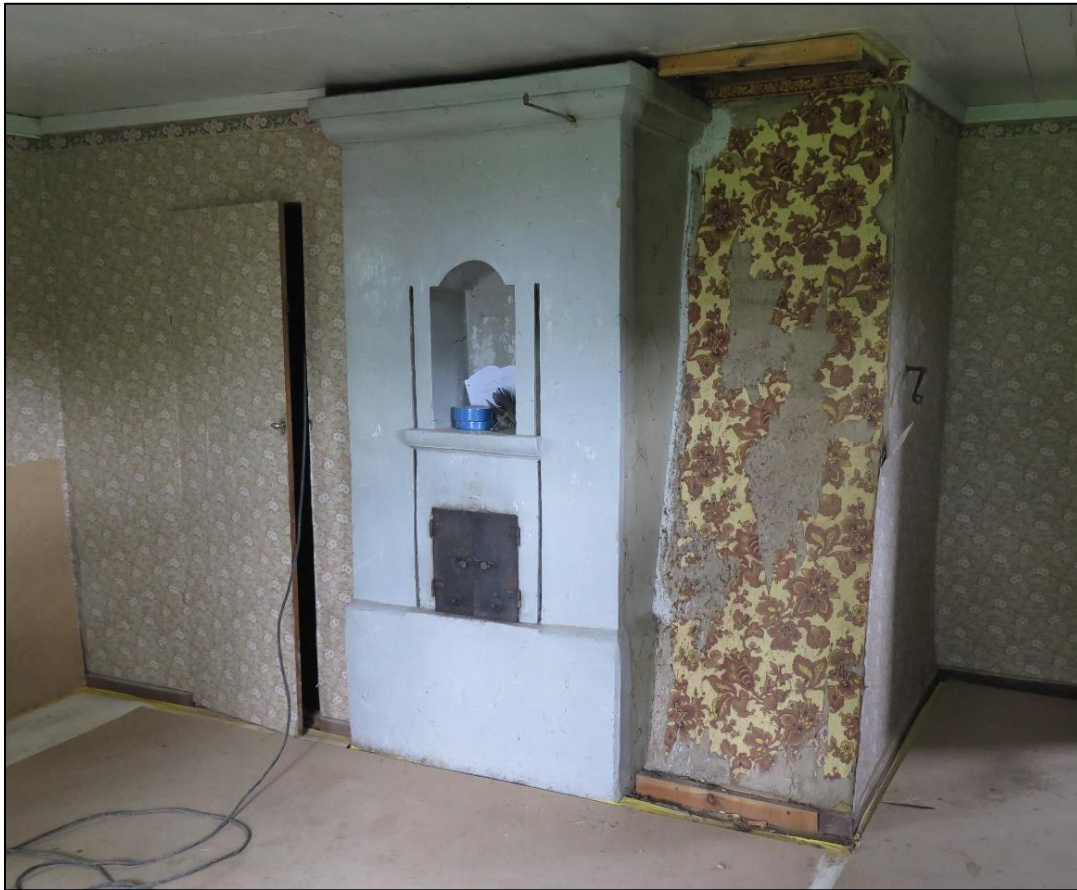
Övre salen och rörspisen med påbyggnaden på murstocken till höger om rörspisen borttagen. Foto, Lars Bergström 2022-05-25.
