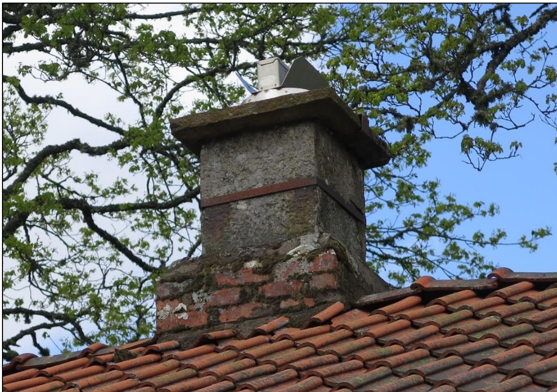
Skorstenen från sydost före åtgärder. Foto Lars Bergström 2021-05-17.
