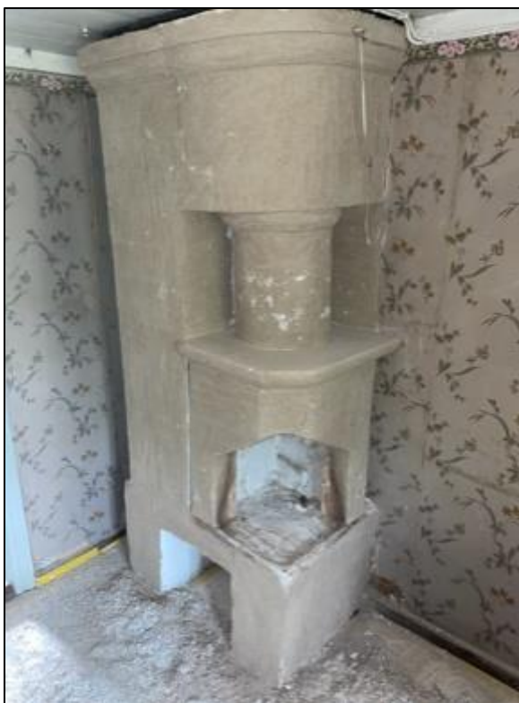
Rörspisen i nedre kammaren. Till vänster, färg bortskrapad, foto Mattias Wallin-Brandt. Till höger efter åtgärder, foto Lars Bergström 2022-08-10.
