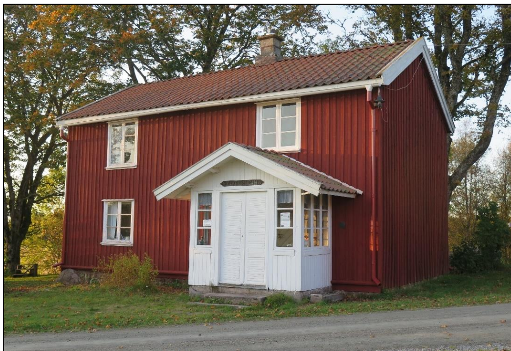
Bostadshuset från sydost före åtgärder och renovering av skorstenen. Foto Lars Bergström 2019-10-01.
