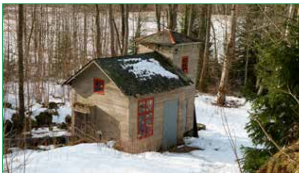
Den nedre kraftstationen.
