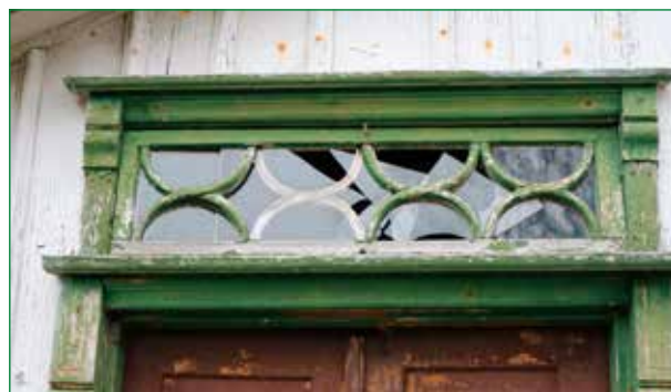
Överljusfönster på bostadshusets snedtäcka.
