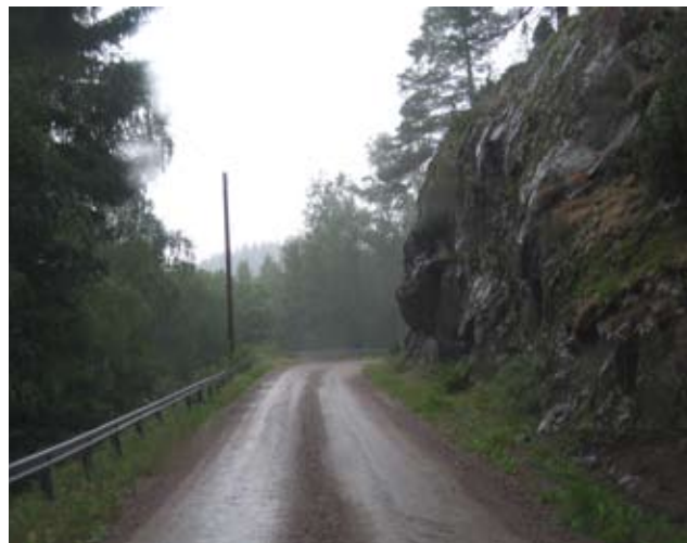
Bergskärning utförd på 1920-talet.
