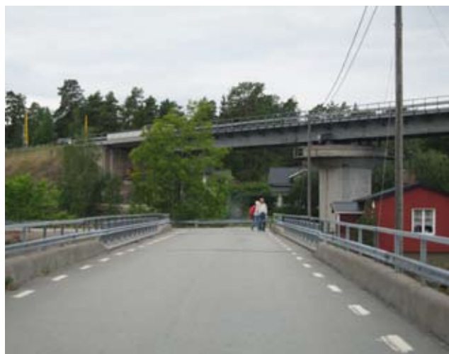
Den moderna vägbron går rakt och gent över sundet.
