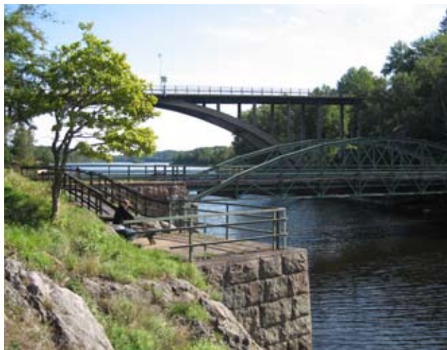
Närmast kameran fundament från järnvägsbron, där bakom den äldre vägbron och längst bort dagens bro.
